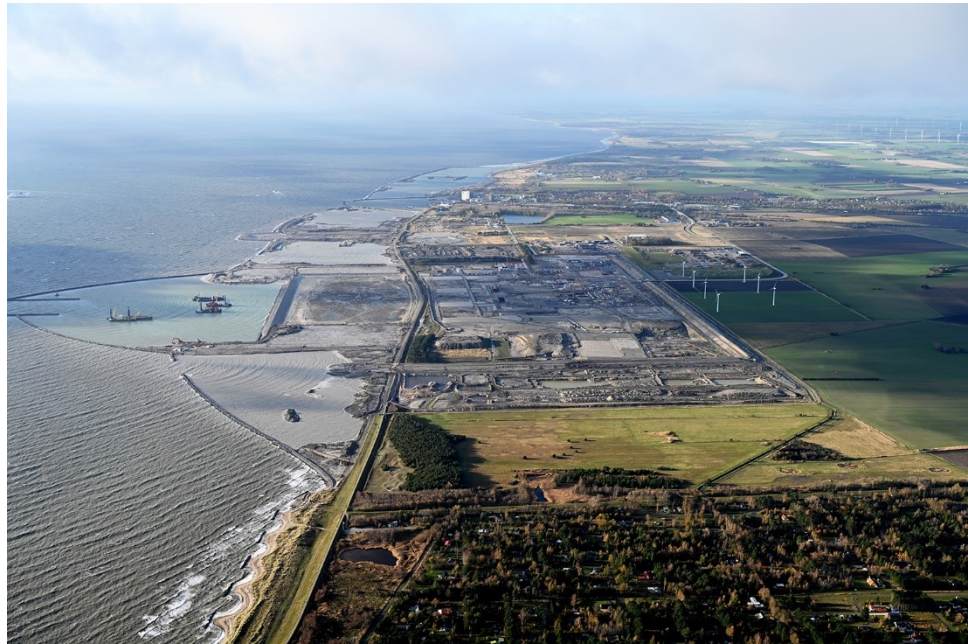
Byggepladsen på dansk side i efteråret 2021.
