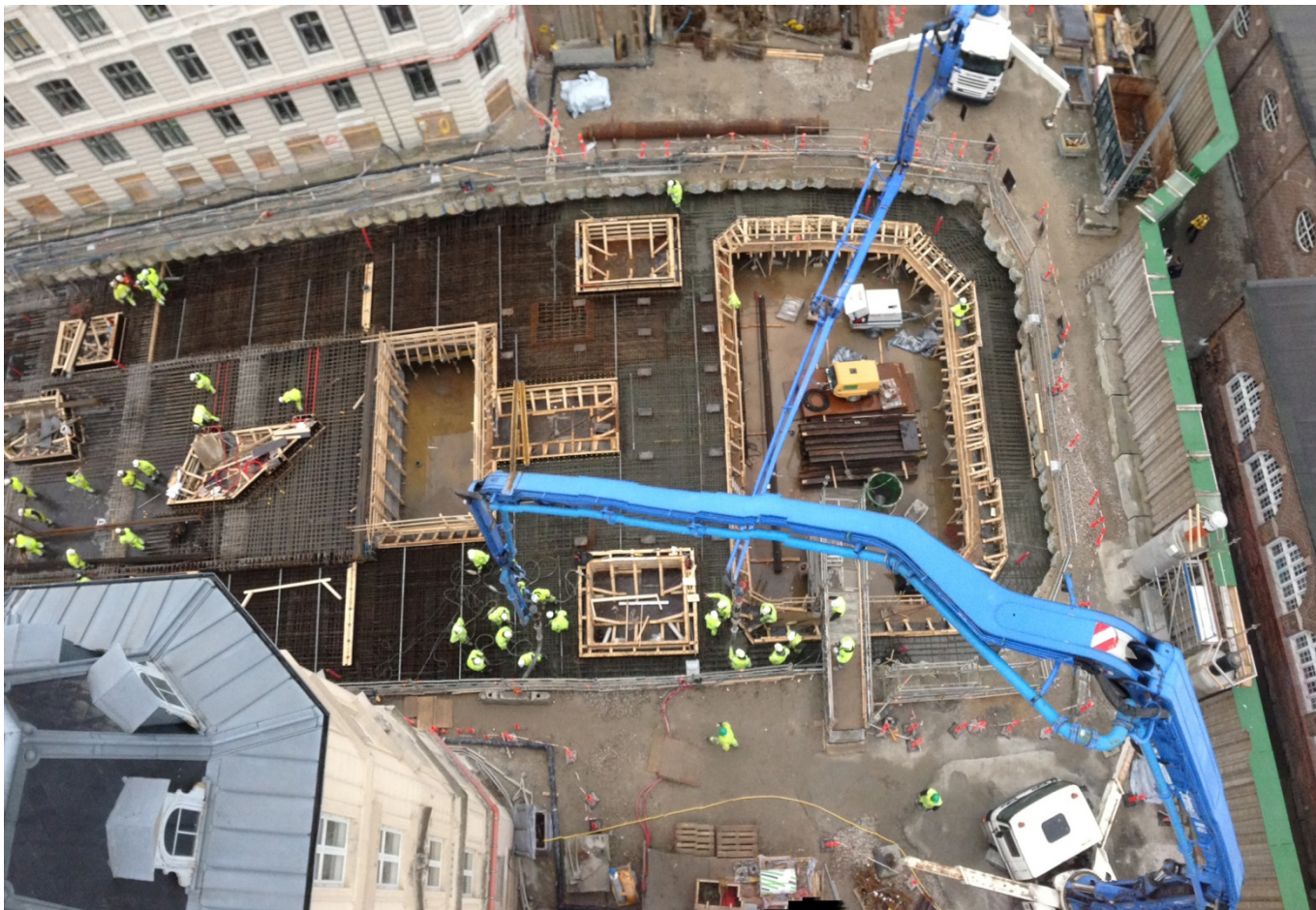
Stationsbyggeri ved Københavns Hovedbanegård.
