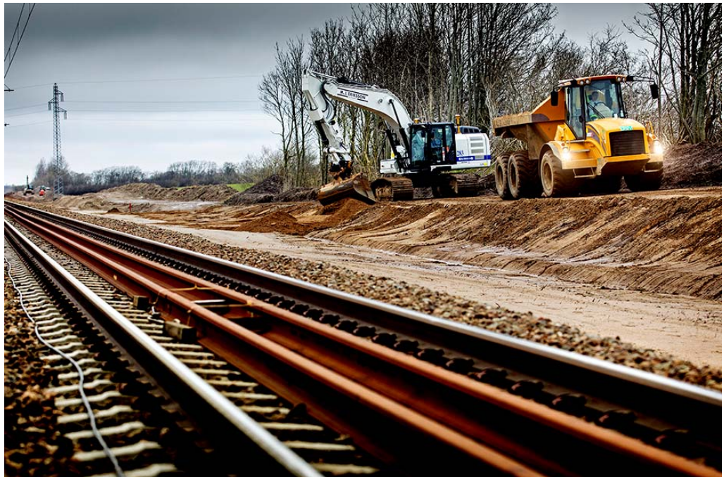
Sporlægning på strækningen mellem Vamdrup og Vojens.
